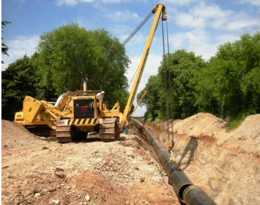
Attività di posa di un metanodotto
